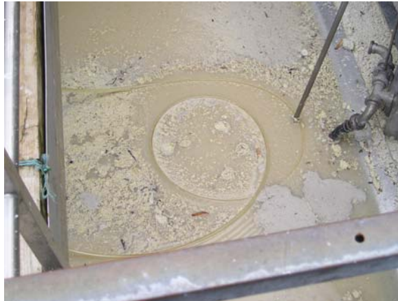
Die Fettschicht wird durch den Ölaufnahmeschlauch zerschlagen und Fett haftet an dem Ölaufnahmeschlauch
