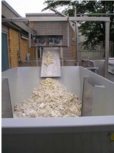
Sammelcontainer mit seitlichen Steck-sieben
